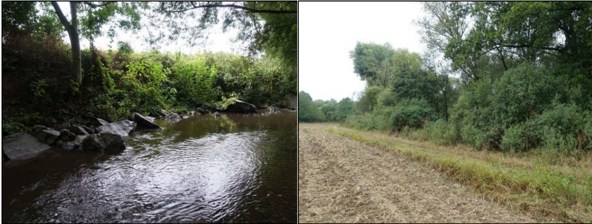
Abb. 13: Versteinung des Prallhangs zur Sicherung angrenzender Flurstücke
