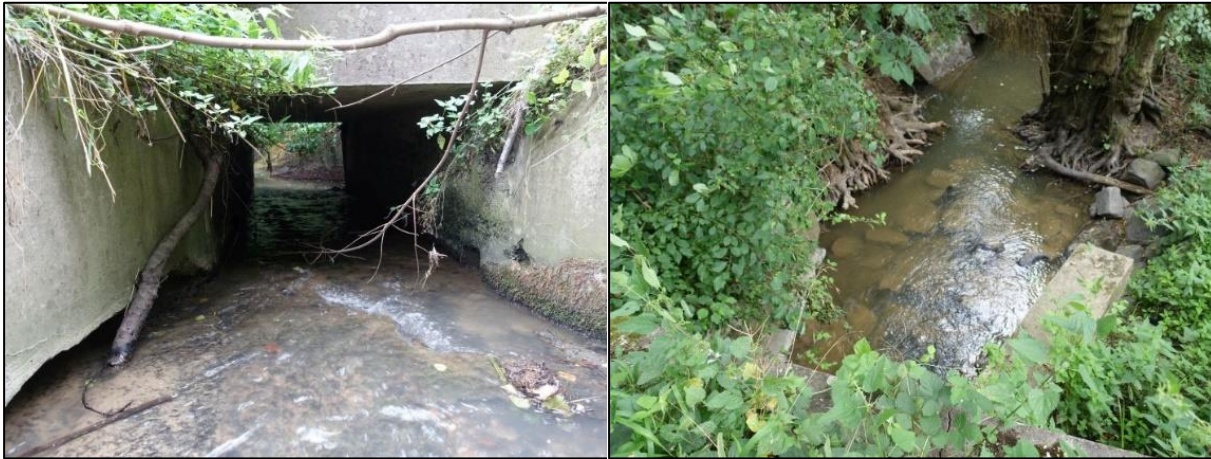
Abb. 16: Wanderhindernis 34991 - Blick bachabwärts in das Kreuzungsbauwerk rein
